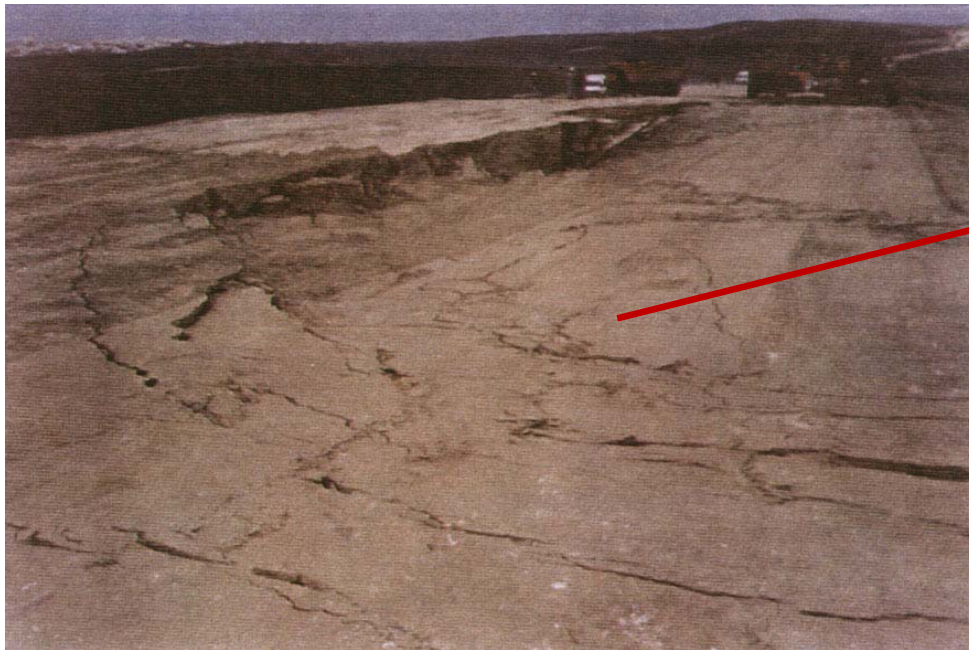
Ejemplo de rotura “sin drenaje”. Terraplén sobre marisma (Variante de Lebrija, Sevilla).
